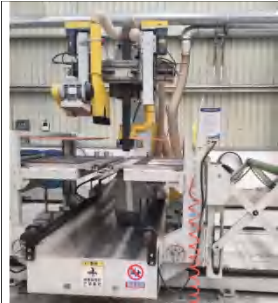
板材带锯切割废气收集
