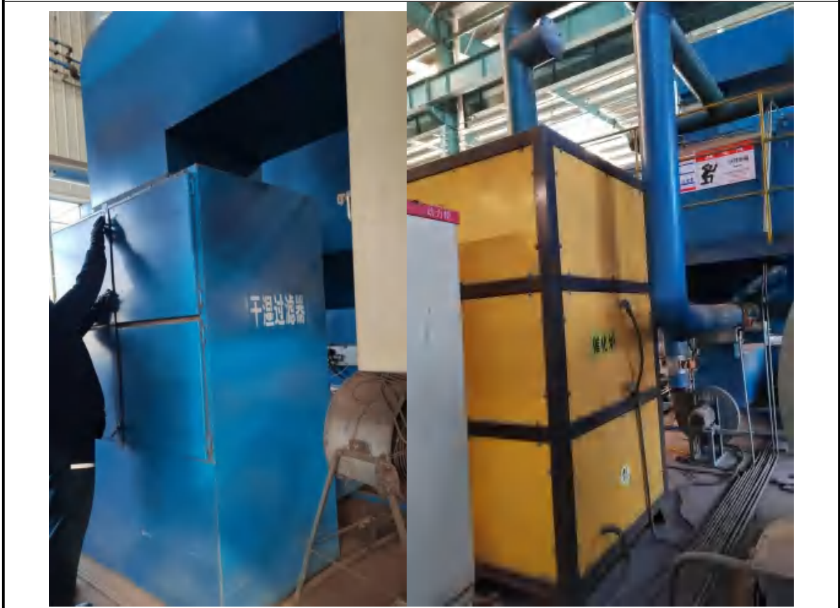
喷漆房废气处理设施：干式过滤器+过滤棉+活性炭吸附浓缩-脱附催化燃烧净化装置
