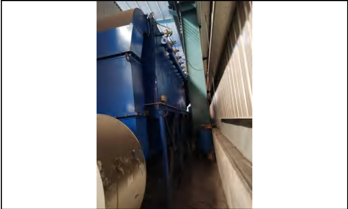
喷漆房废气处理设施：干式过滤器+过滤棉+活性炭吸附浓缩-脱附催化燃烧净化装置
