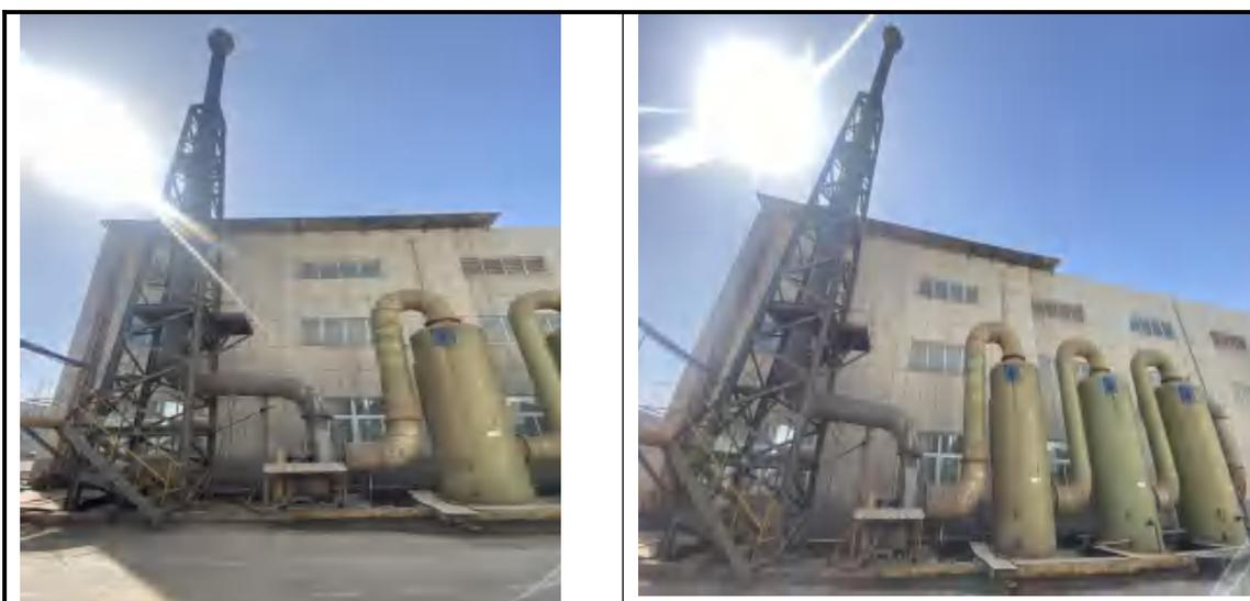
**布袋除尘器、三级水喷淋+吸附剂吸附+排气筒 P2**
