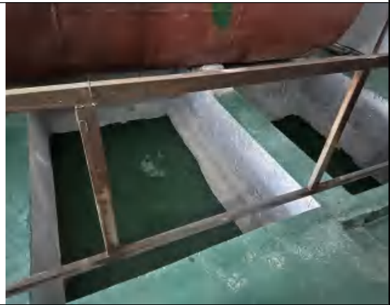
废铅蓄电池储存区导流沟
