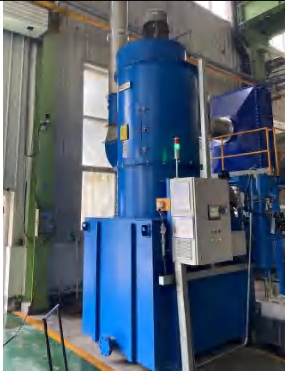
下料过程废气处理设施：滤筒式袋式除尘器
