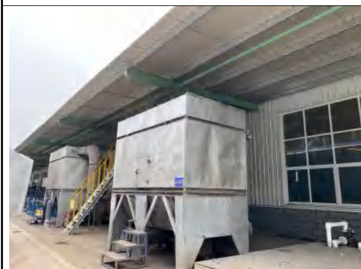
小抛丸废气处理设施：滤筒式袋式除尘器
