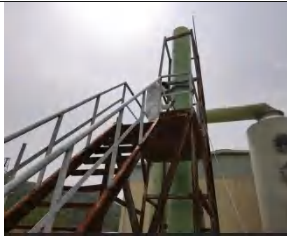
附件 5：现场监测照片
