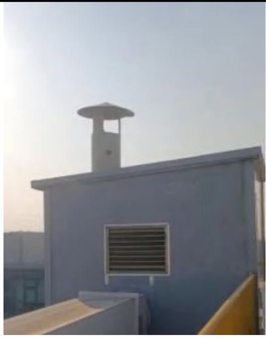
实验室有机废气排气筒
