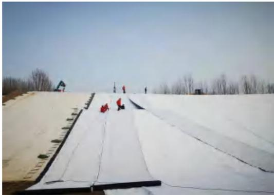
高抗拉滤排板 (1.2mm×10mm) +GCL 膨润土垫 (4800g/m<sup>2</sup>)
