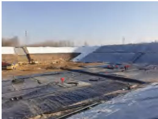
2.0mm 厚光面 HDPE 土工膜+400g/m<sup>2</sup> 长丝非织造土工布
