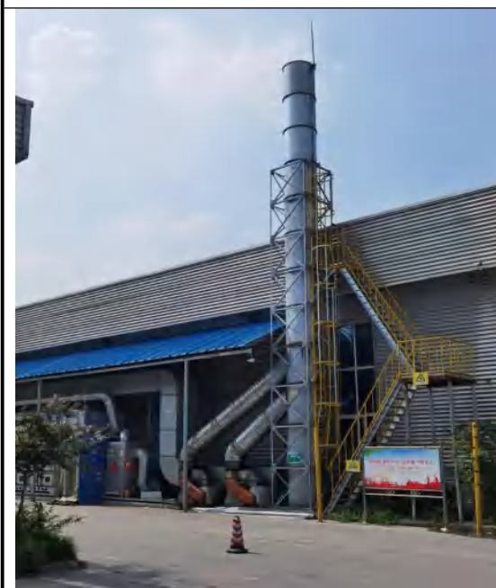
工艺废气催化燃烧装置+DA001 排气筒
