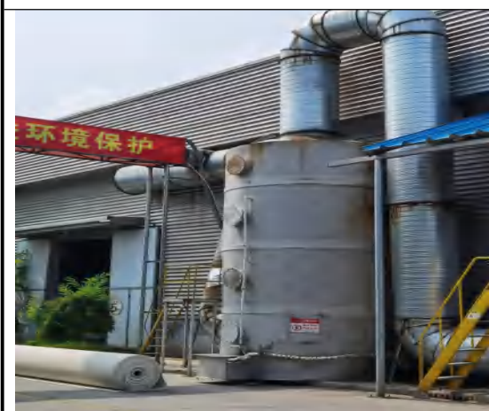
工艺废气催化燃烧装置+DA001 排气筒
